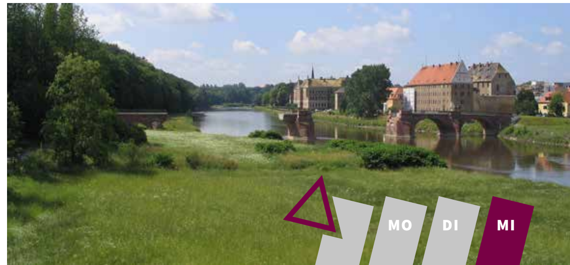
Brückenschaden nach der Flut in Grimma
