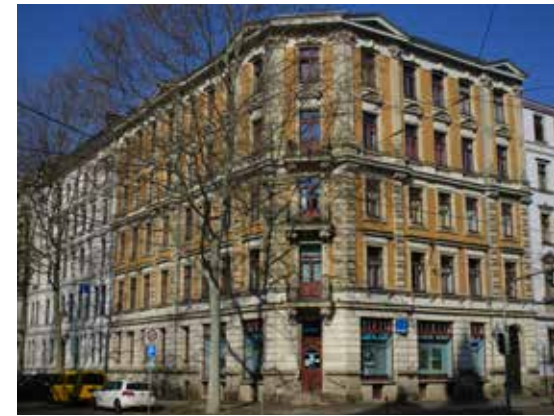
Gründerzeitliche Bebauung im Waldstraßenviertel
